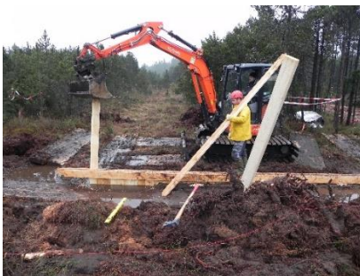
Einbau Spundwand
